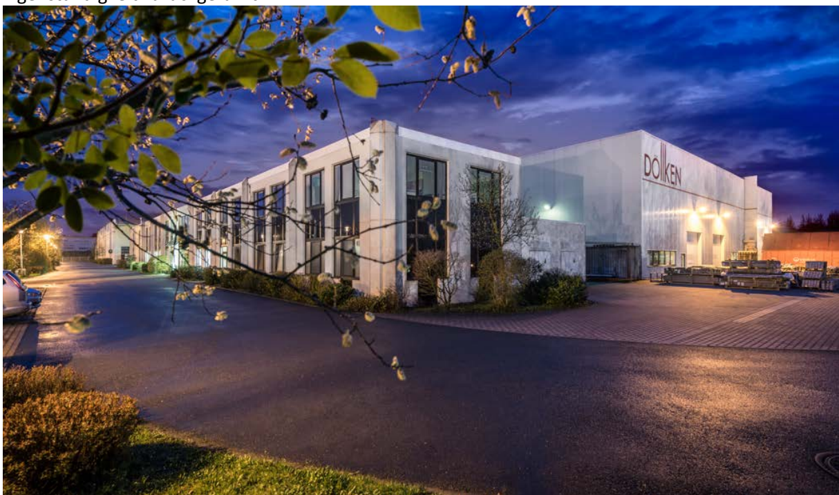
BU: Die Zentrale der Döllken-Weimar GmbH in Nohra
