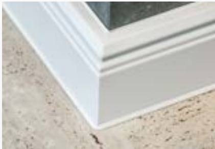
Profilstöße & Fugen problemlos schließen
